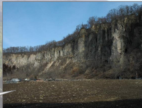
防災工事後のJR万座・鹿沢口駅裏崖
